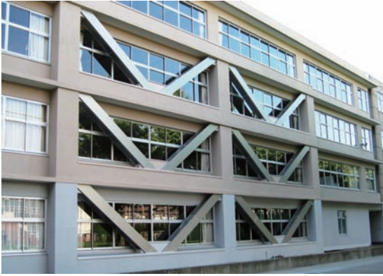
補強が完了した校舎
