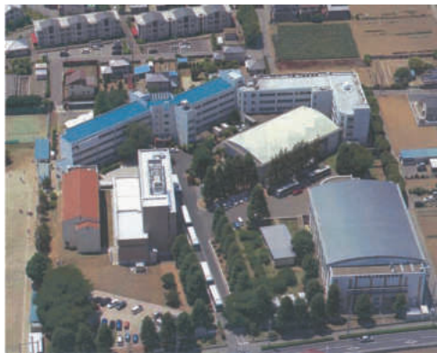
校舎航空写真（平成 25 年）
