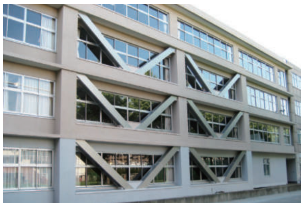
耐震補強の完了した高等部校舎
