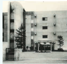
開学初期の短期大学校舎玄関 (旧1号館)
